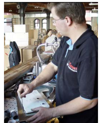
Monteur Ad Janssen, van Oomen Koeltechniek bezig met de installatie in restaurant 'Fifteen'
